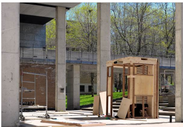
Construction d'un prototype à l'échelle 1:1
